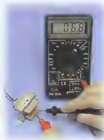
Figura 8.26. Prueba del voltaje de CA en el secundario de un transformador
